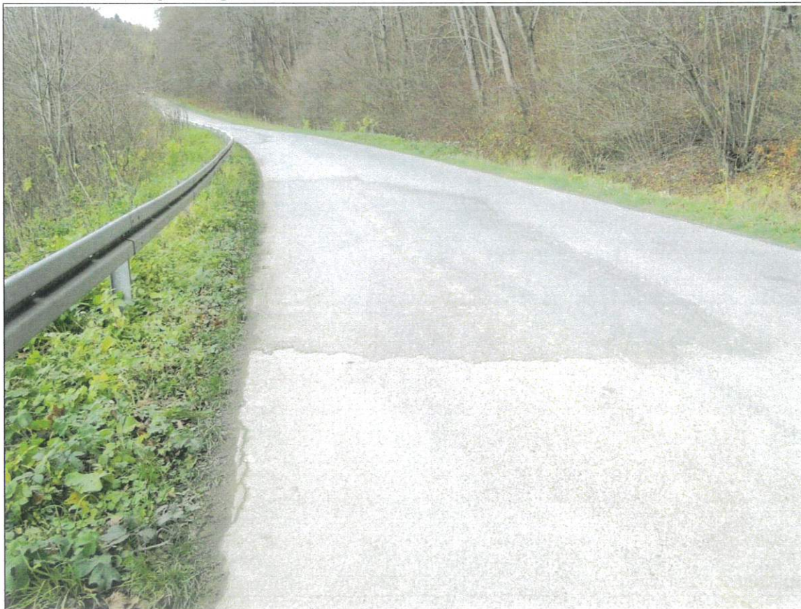
Widok na fragment naprawionej nawierzchni asfaltowej
